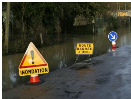
Route inondée barrée – Photographie MEEM
