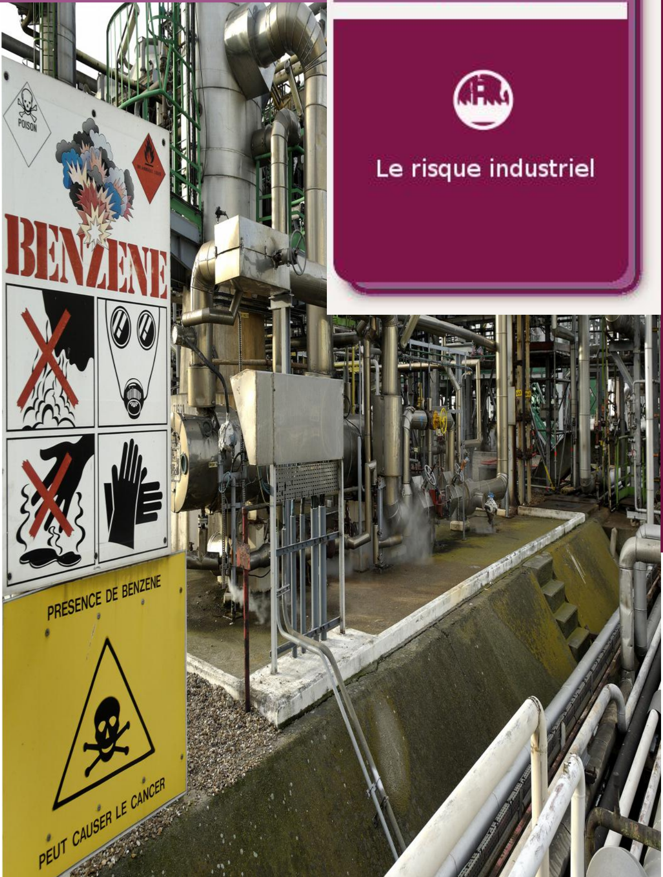
Raffinerie - Photographie MEEM
