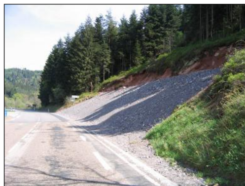
Glissement de terrain à Bois-de-Champs – Photographie le 24/04/2007 BRGM
